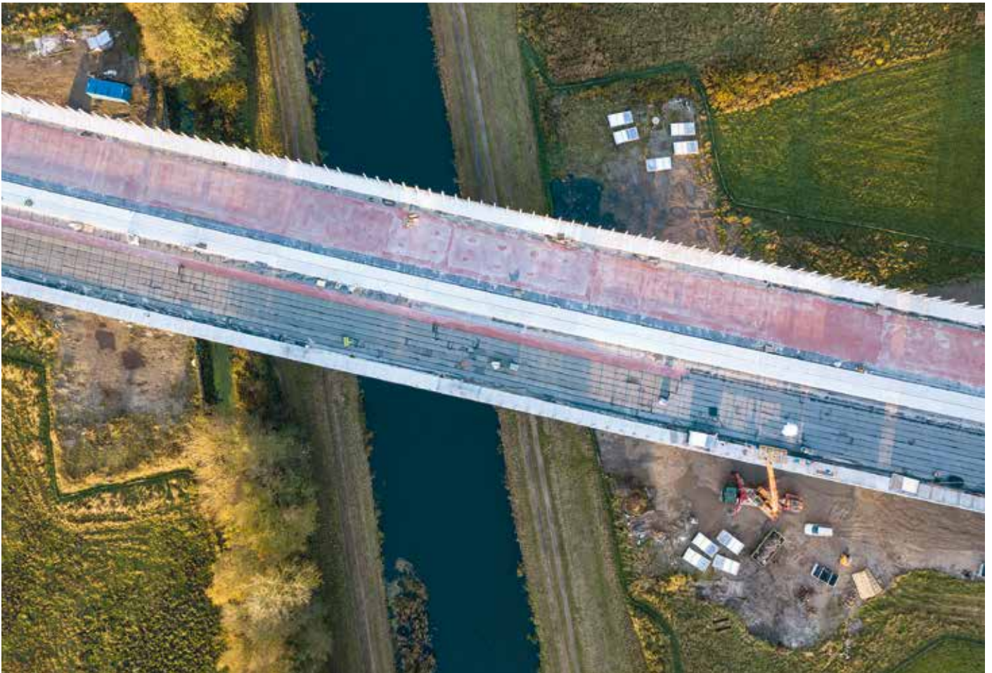
Brückenbauwerk über die Müritz-Elde-Wasserstraße aus der Vogelperspektive
