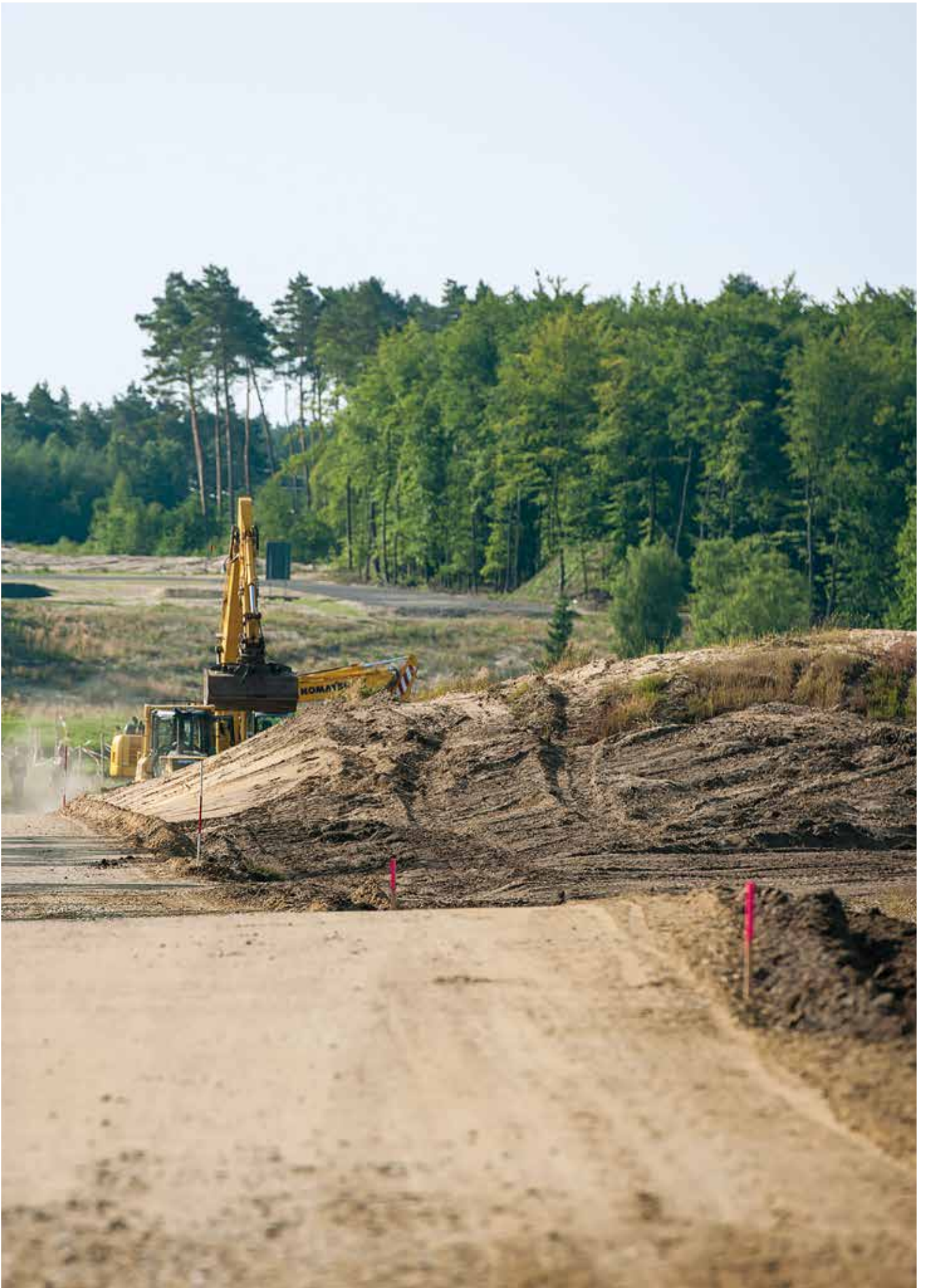
Bodenbewegungen bei der Planierung der Trasse
