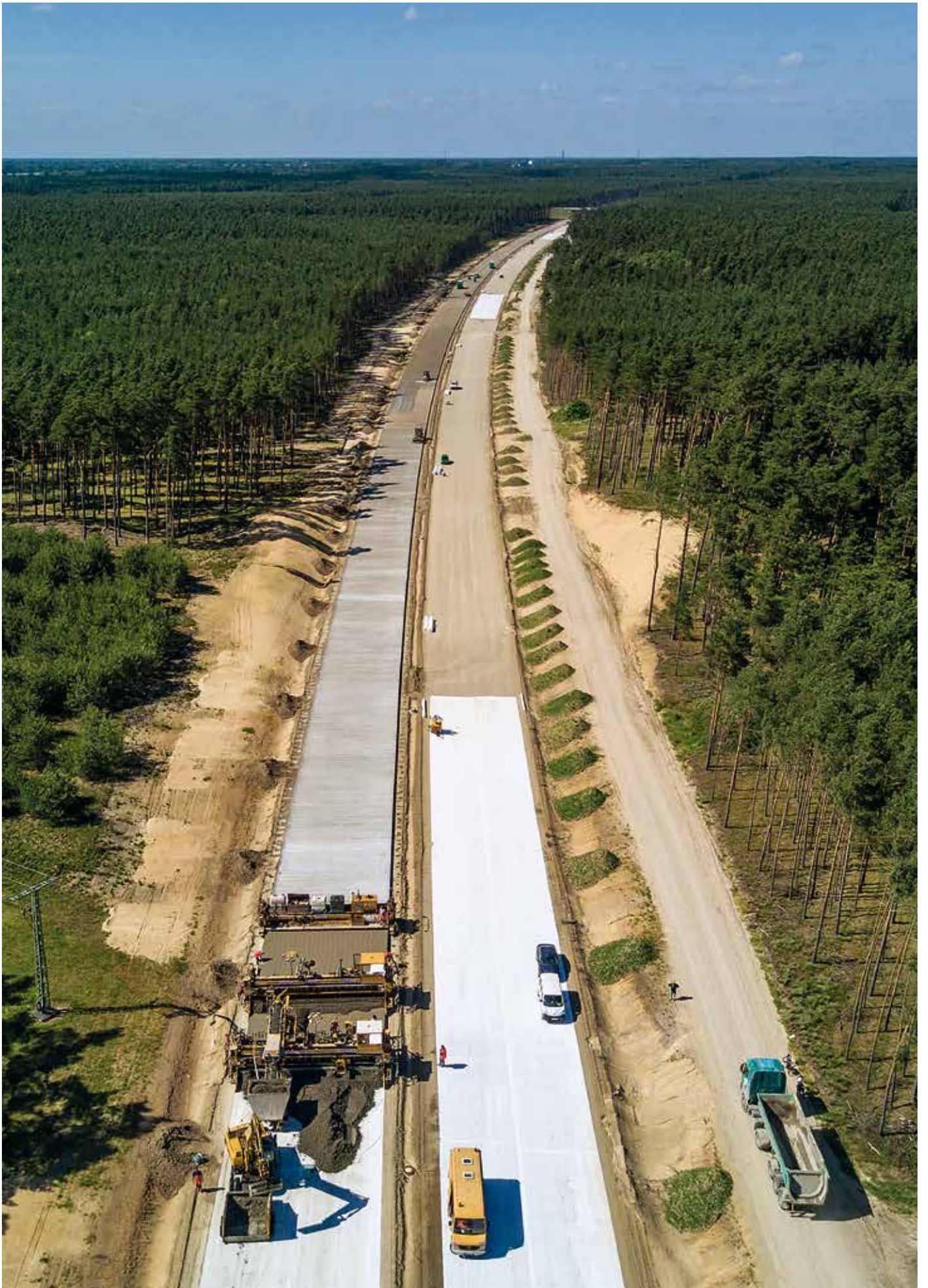
Fertigereinsatz für den Betonoberbau
