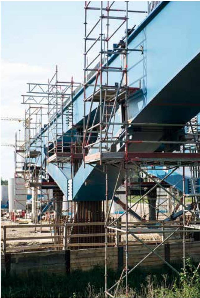
Stahlträgermontage der Eldetalbrücke
