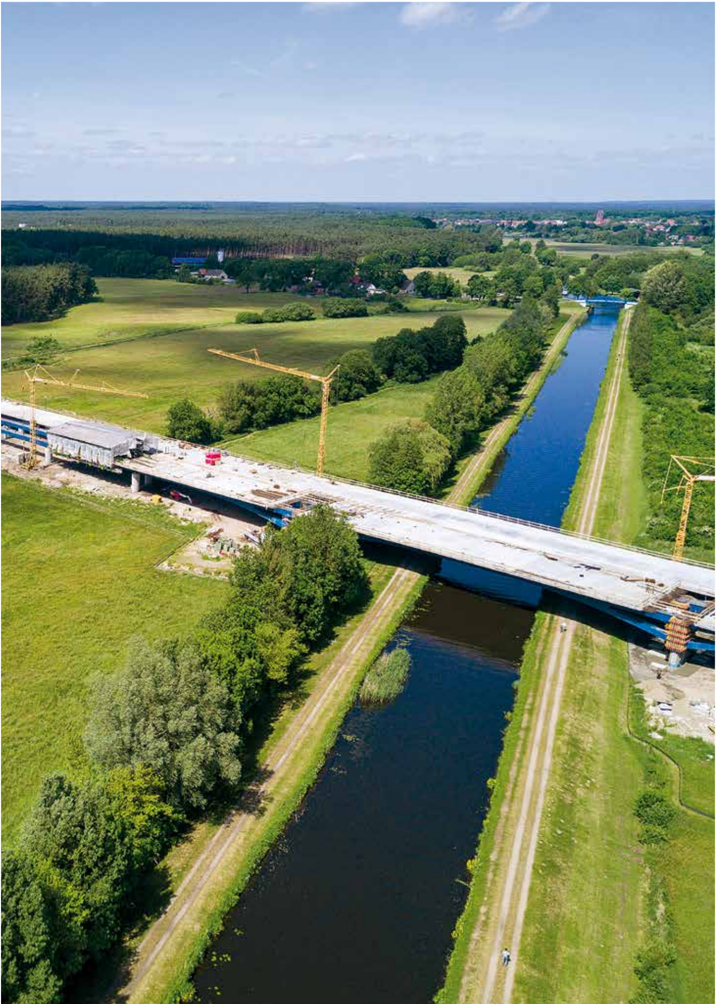
Brückenbau über die Müritz-Elde-Wasserstraße
