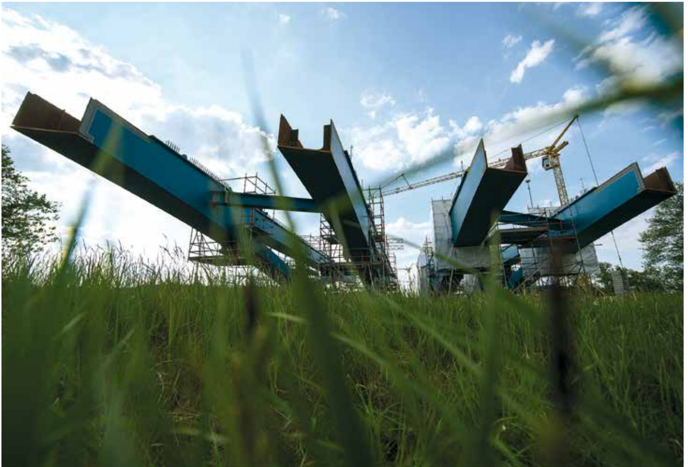
Stahlträgervorschub für die Eldetalbrücke
